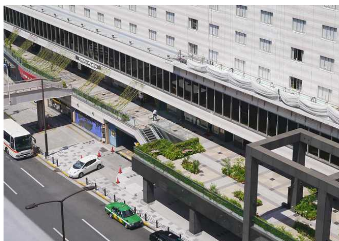
北側オープンコリドール全景
