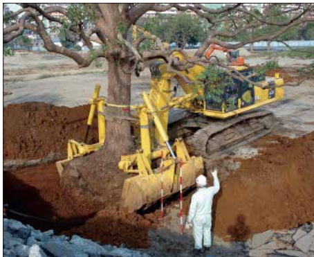
④ あらかじめ堀削しておいた植穴におろし、傾きなどを調整
