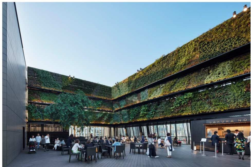
四季の移り変わりや植物の豊かな色彩を楽しむことができる 大規模な壁面緑化が魅力のKIRIKO TERRACE (キリコテラス) (写真=© Koji Fujii / Nacasa&Partners Inc.)
